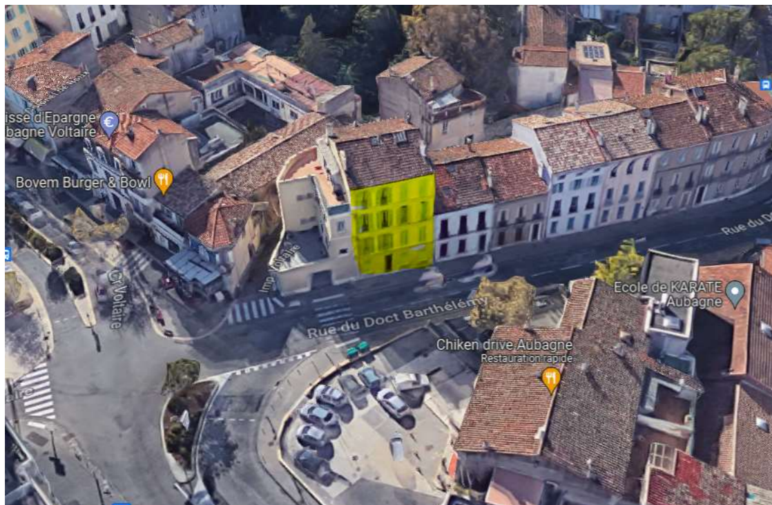
Bâtiment en R+3 – Rue Barthelemy
