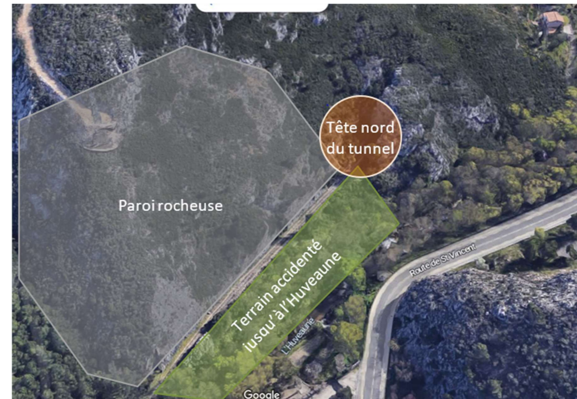
Tête nord du tunnel du Roquevaire
